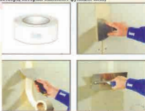
Заделка швов с применением бумажной ленты:
